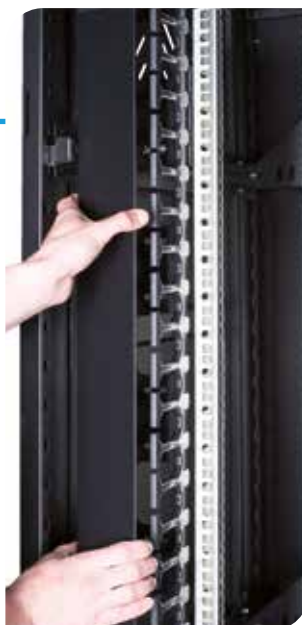
Câble management latéral avec caches pivotants ou amovibles
